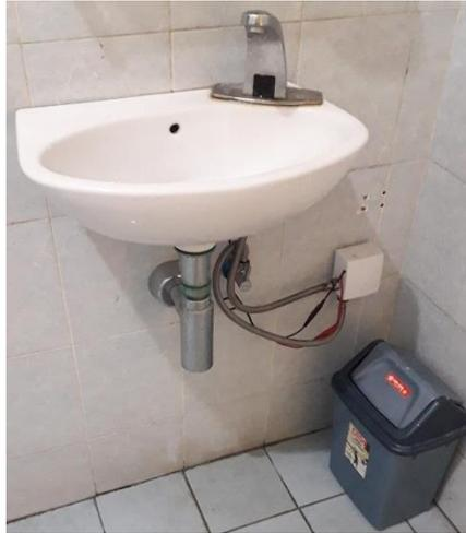
Gambar 57 Kran Otomatis dalam rangka efisiensi penggunaan air di Kampus
